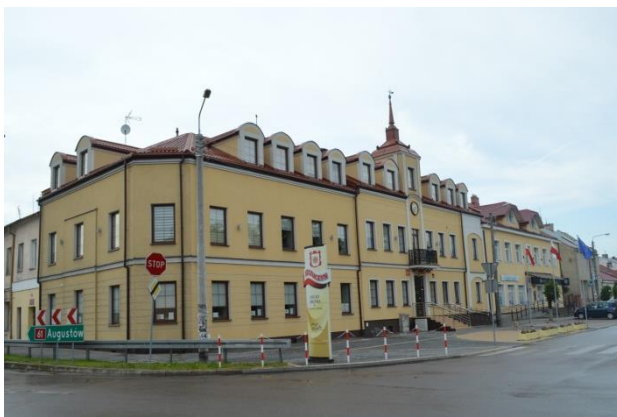
Zmodernizowany budynek Urzędu Miejskiego w Szczuczynie. Fot. autor tekstu.
